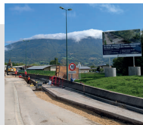
Les premiers travaux menés par la Régie des Eaux ont débuté en septembre 2025.
